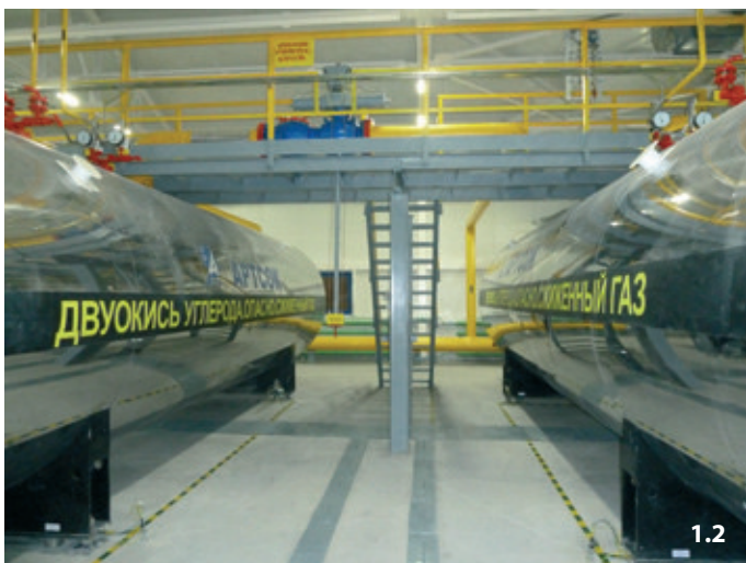
Рис. 1. 1. Здание станции газового пожаротушения. 2. Установка газового пожаротушения на базе 4-х МИЖУ.
